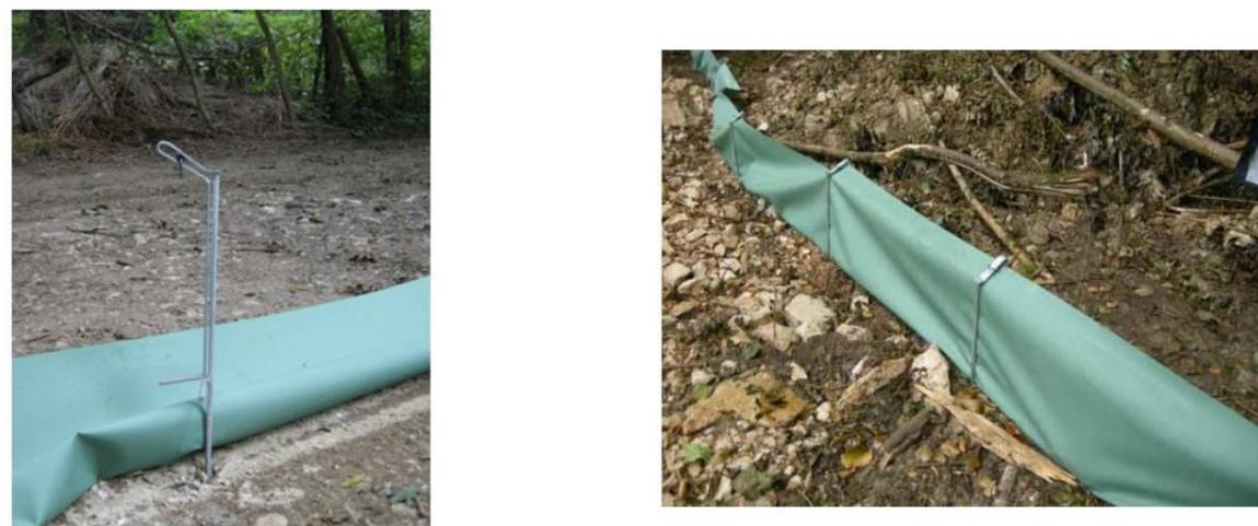
Figure 22 : Exemple d'une barrière avec bavolet et bêche lisse en cours de montage © M. Gigleux, Cerema Est
