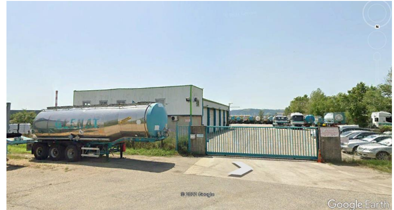
Figure 9 : Entrée de Cottard Glénat (source : google street view, 2022)
